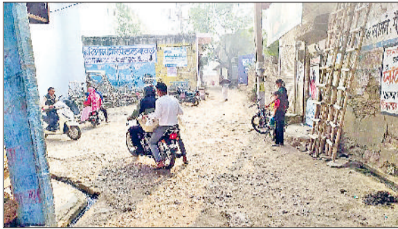
रेवाड़ी। बावल की एक गली में जर्जर सड़क, बावल में सड़क पर लगा कचरे का ढेर।
